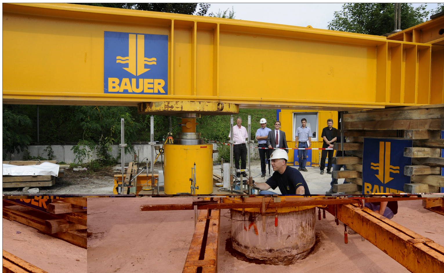
Mehrere Messinstrumente sind auf dem Bohrpfahl befestigt. Die gelbe Presse darauf drückt nach oben gegen den Stahlträger, der an beiden Seiten von Stahllitzen nach unten gezogen wird. Sebastian Bosch erklärt, wie's funktioniert. – Foto: Binder
