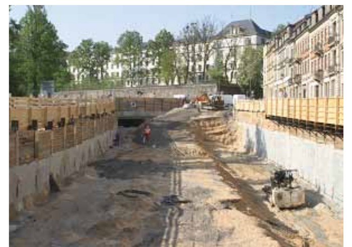
Der in offener Bauweise errichtete Tunneltrög ist nur wenige Meter von der gründerzeitlichen Bebauung entfernt.
