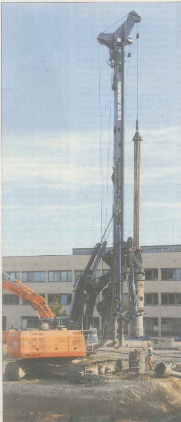
Schweres Gerät ist auf der Erweiterungsfläche der Hochschule im Einsatz. Bis Ende September sollen 400 Bohrpfähle bis zu 14 Meter tief in den Untergrund getrieben werden. – Foto: Binder
