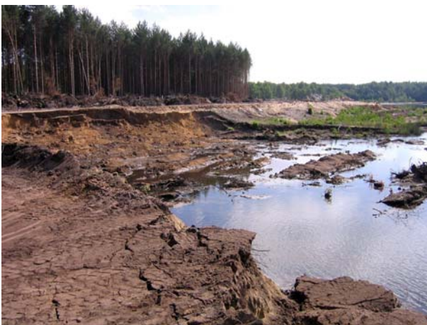
Bild 2: Rutschung im Vorfeld einer RDV, Höhe der Abrisskante ca. 4 m, davor sind staffelförmige Brucherscheinungen und die horizontale Ablagerung der Massen sichtbar. Der bereits verdichtete Damm links im Bild blieb erhalten.
